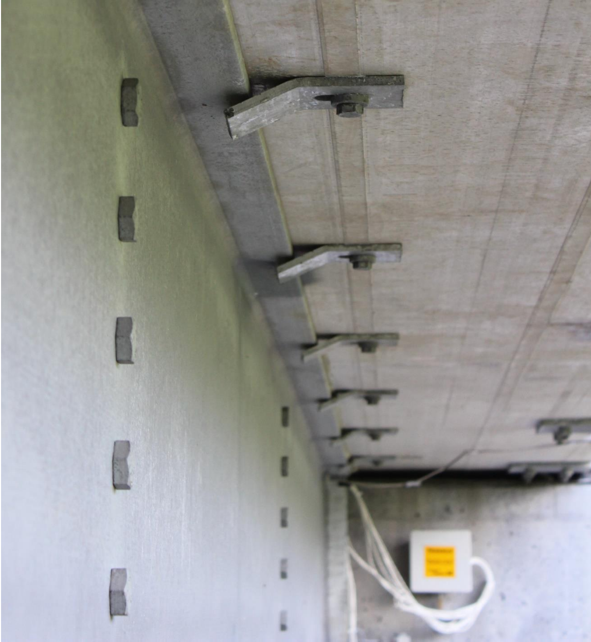
Figure 2-4 : Brides de fixation entre une poutre et le platelage Ambroise (crédit photo : Centre de recherche sur l'aluminium – REGAL, juillet 2018).
