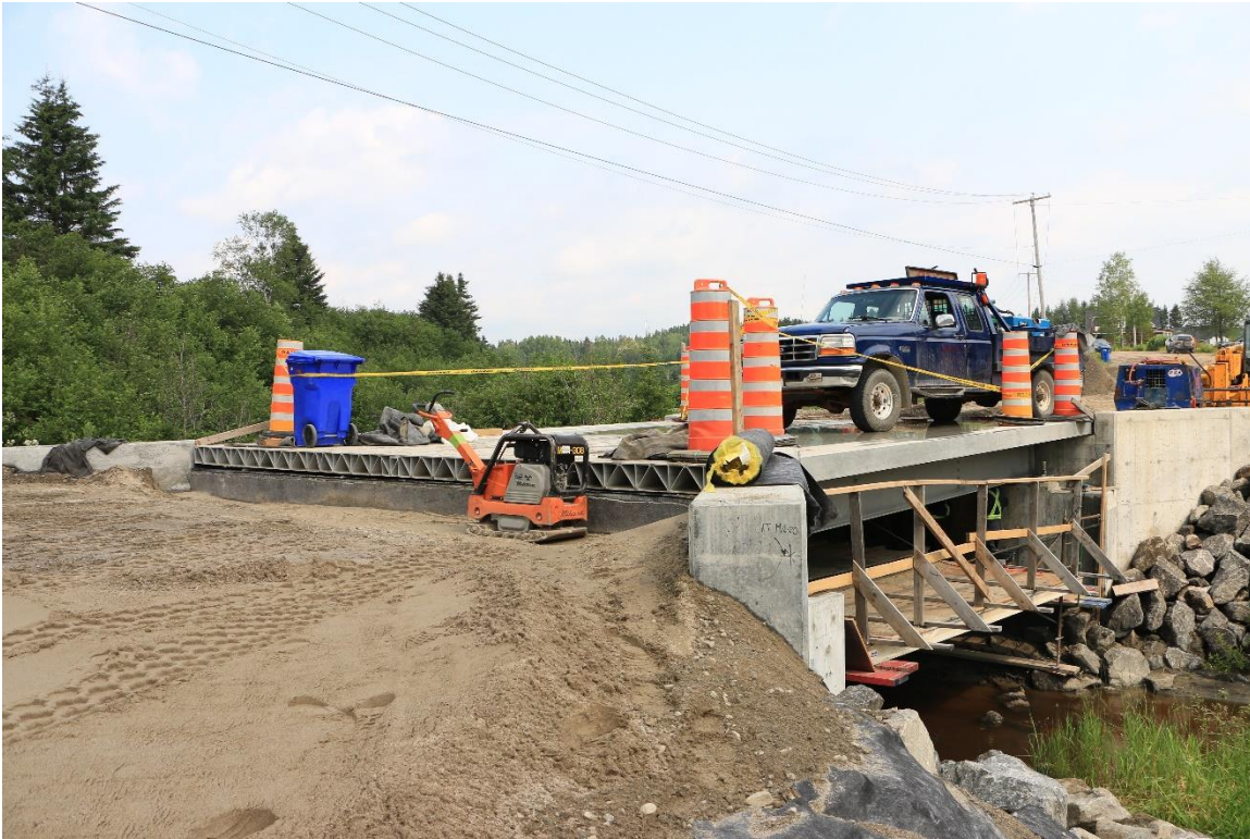
Figure 3-1 : Chantier de construction du pont P-17948 (crédit photo : Centre de recherche sur l'aluminium – REGAL, juillet 2015).
