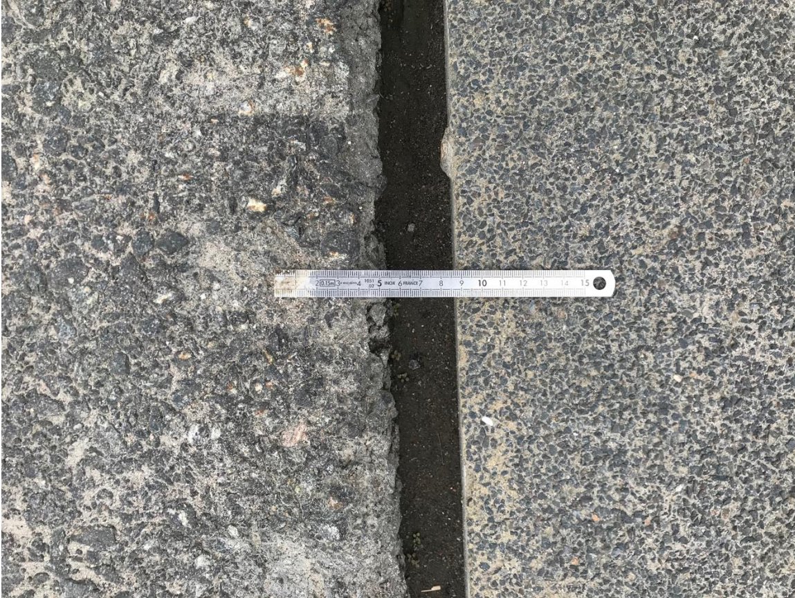
Figure 4-6 : Espace entre le platelage et la chaussée.
