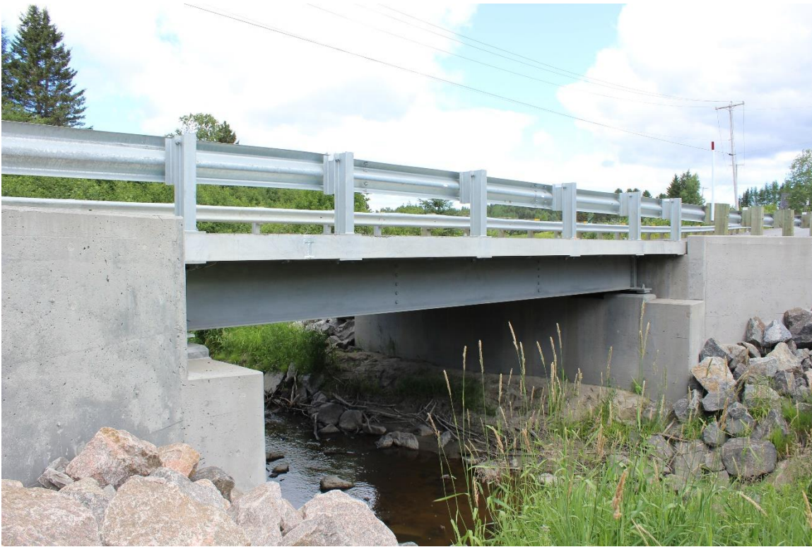
Figure 2-2 : Pont à platelage en aluminium de Saint-Ambroise (crédit photo : Centre de recherche sur l'aluminium – REGAL, juillet 2018).
