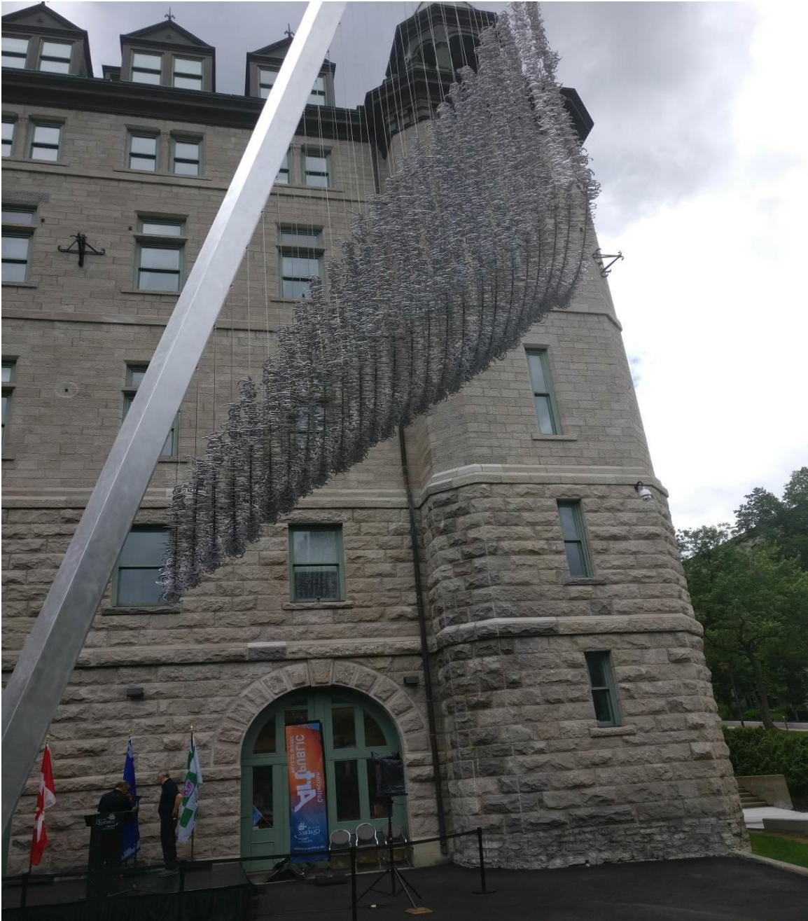
Figure 14 - Mât incliné de la sculpture comportant 25 colliers soutenant 9 520 crochets suspendus (Gracieuseté de L. Larouche)
