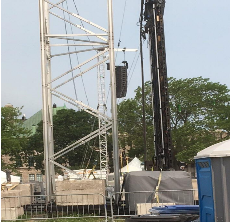
Figure 1 - Pont d'éclairage vertical haubané (Gracieuseté de L. Larouche)
