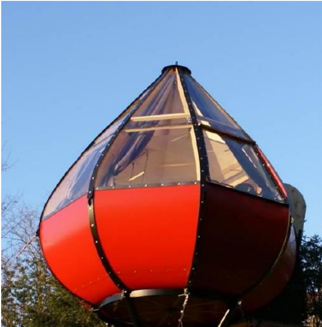
Figure 11 - Portion supérieure de la tente en forme de goutte d'eau (Gracieuseté de Biome Canada)
