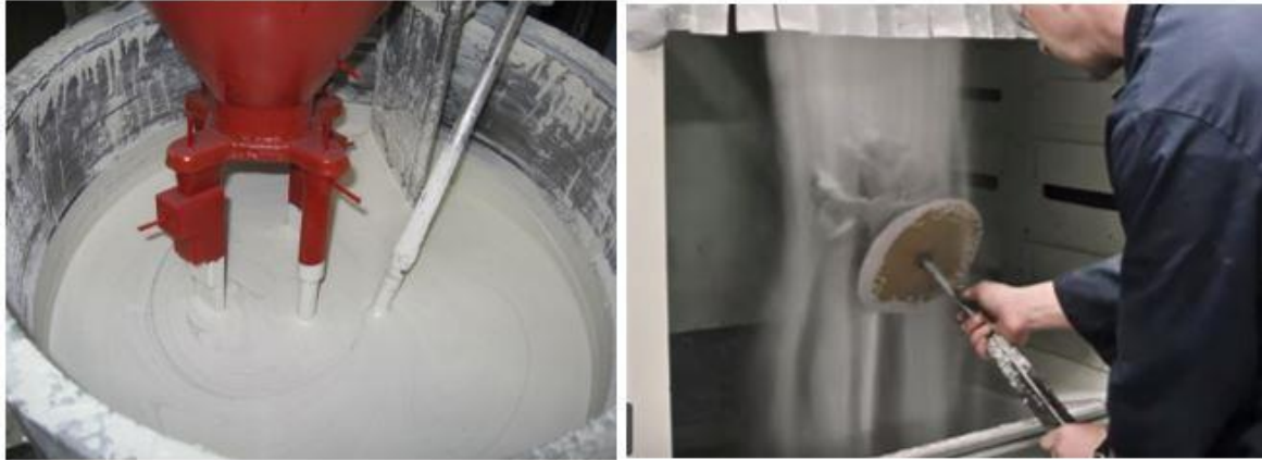
Figure 5. Enrobage par couches successives de coulis et stucco.
