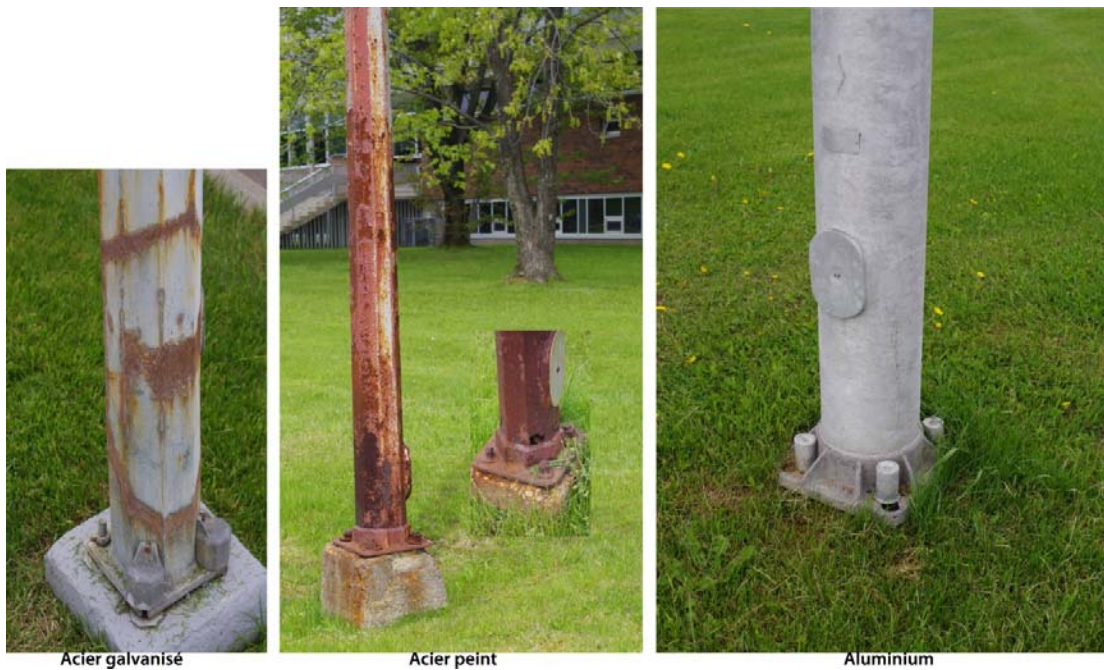
Figure 3 – Poteau d'éclairage de ville; acier galvanisé, acier peint et aluminium
